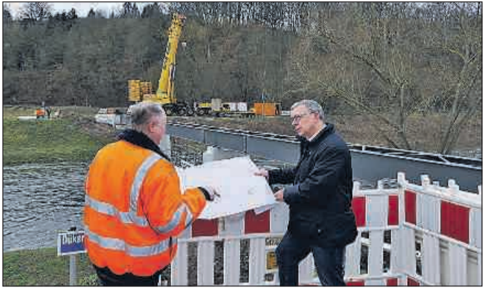
Baudezernent Michael Sonntag (rechts) begleitete den Baufortschritt vor Ort persönlich. Foto: Stadt Gera/Frances Schlesier
