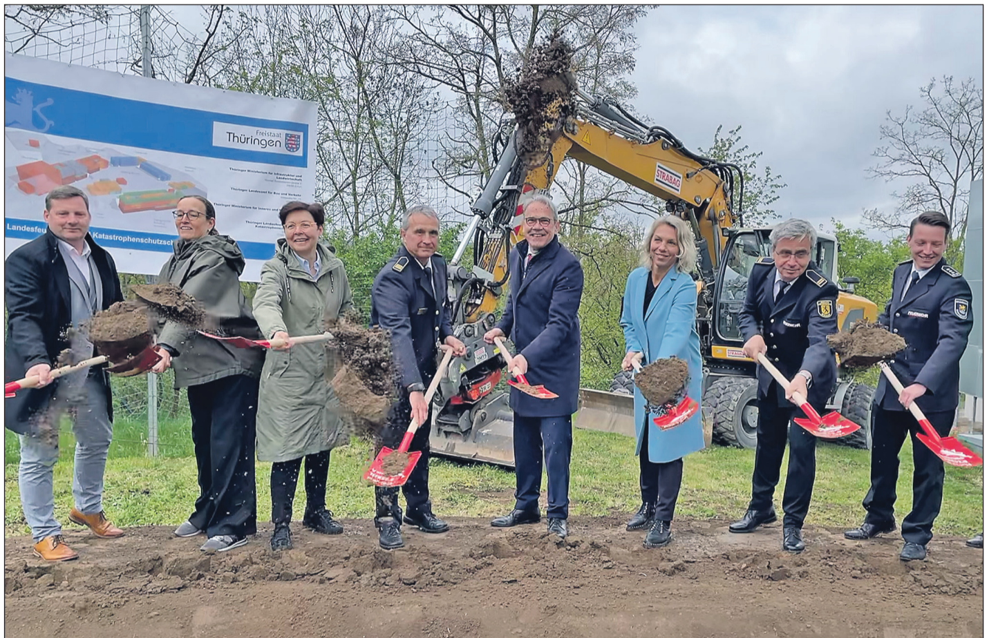
Mit Susanna Karawanskij, Heike Taubert und Georg Maier waren drei Thüringer Minister am Montag vor Ort, um den Spatenstich zur Erweiterung und komplexen Sanierung der Thüringer Landesfeuerwehr- und Katastrophenschutzschule Bad Köstritz zu vollziehen. Foto: Jens Lohse
